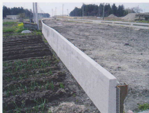
<施工場所：新潟県村上市「荒川道路」>
