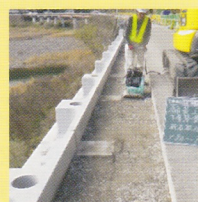
埋戻し、路盤工施工
