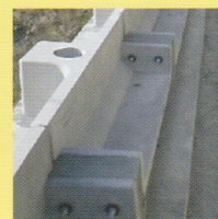
間詰めコンクリート完了
