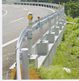
L型擁壁（天幅前面に合わせた例）
