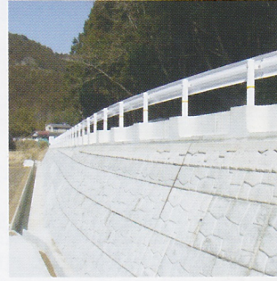
大型ブロック積擁壁
