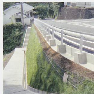
ジオテキスタイル補強土壁
