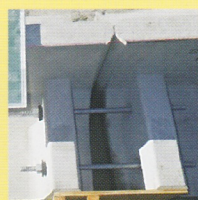
連結筋設置完了
