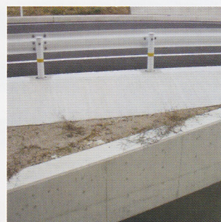
盛土 (BOX上の盛土)
