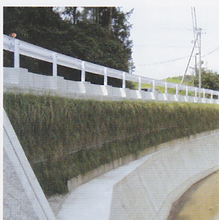
ジオテキスタイル補強土壁
