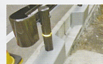
補修した2本の近景
