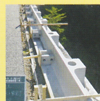
製品・型枠設置完了
