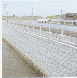
間知ブロック積擁壁
