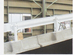
縦断16%の設置確認
