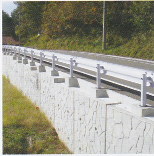
L型擁壁（天端部分を外した例）
