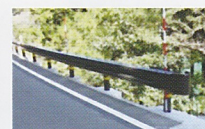
補修後の全景
