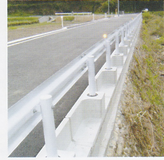
既設石積擁壁
