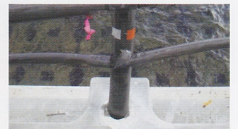
横断方から見た状況
