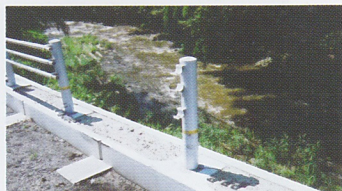
①ガードパイプを取り外した状況
