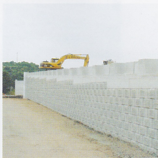
補強土壁 (ジオグリッド)
