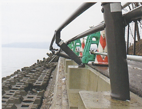
横方向から見た状況
