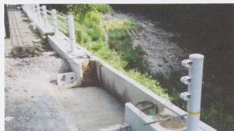
⑤製品を撤去した状況
