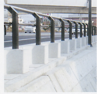
大型ブロック積擁壁
