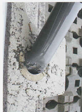
1本目のひび割れ状況
