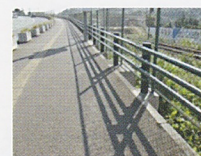
補修した後の全景
