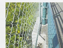
補修した近景
