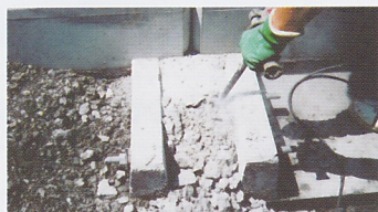
④間詰めコンクリート除去
