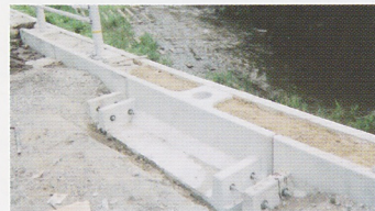
⑥製品を設置した状況
