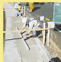
敷きモルタル
