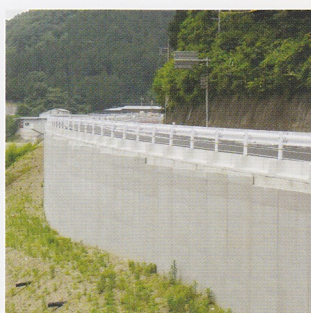
軽量盛土 (発泡モルタル)
