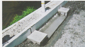
③底版上の土を取り除いた状況
