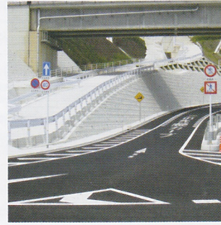
間知ブロック積擁壁
