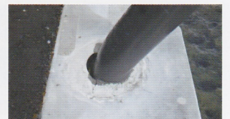
縦断方から見た支柱の変位状況
