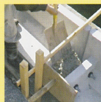
コンクリート打設状況
