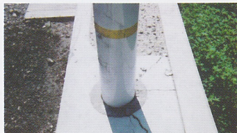
②埋め込み部分のひび割れの状況
