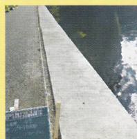
均しコンクリート
