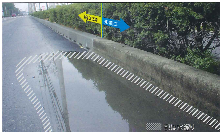
ライン導水ブロック施工済部分と未施工部分の比較
