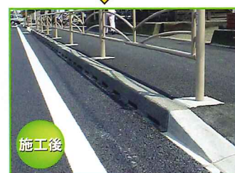
ライン導水ブロック 施工
