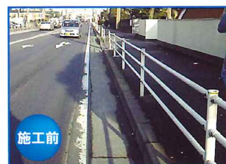
施工前 (L形側溝)
