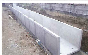
U型1800, 1700×1500×2000mm 開水路(フリーム)への適用例
