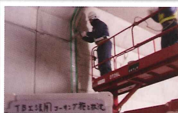
既設および新設10500×5200 既設との接続例(コーキング用)
