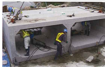
製品寸法(2900+2900)×1500 mm 大断面への適用例
