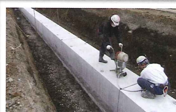
長尺PRC 600×600×4000 長尺ボックスカルバートへの適用例
