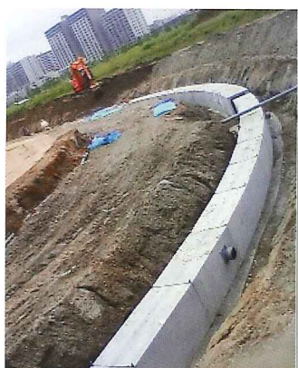
製品寸法: 500×500×2000 ~ 800×800×2000 曲線部への適用例(直線部と同等の連続性、耐震性、水密性)
