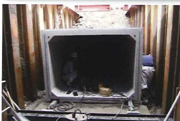
製品寸法: 2000×1500×2000 mm ※液状化地盤における永久ひずみ 1.2%に対応した継手構造 液状化地盤への適用例
