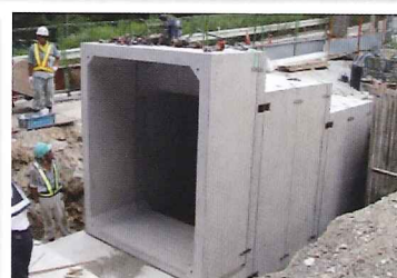
製品寸法(2900+2900)×1500 mm 大断面への適用例
