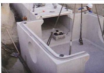
製品寸法: 2000×1500×2000 mm ※液状化地盤における永久ひずみ 1.2%に対応した継手構造 液状化地盤への適用例
