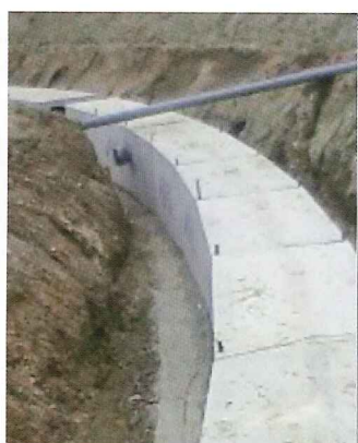
製品寸法: 500×500×2000 ~ 800×800×2000 曲線部への適用例(直線部と同等の連続性、耐震性、水密性)
