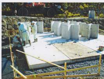
施工据え付け状況
